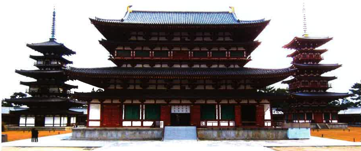
薬師寺 東塔 金堂 西塔
